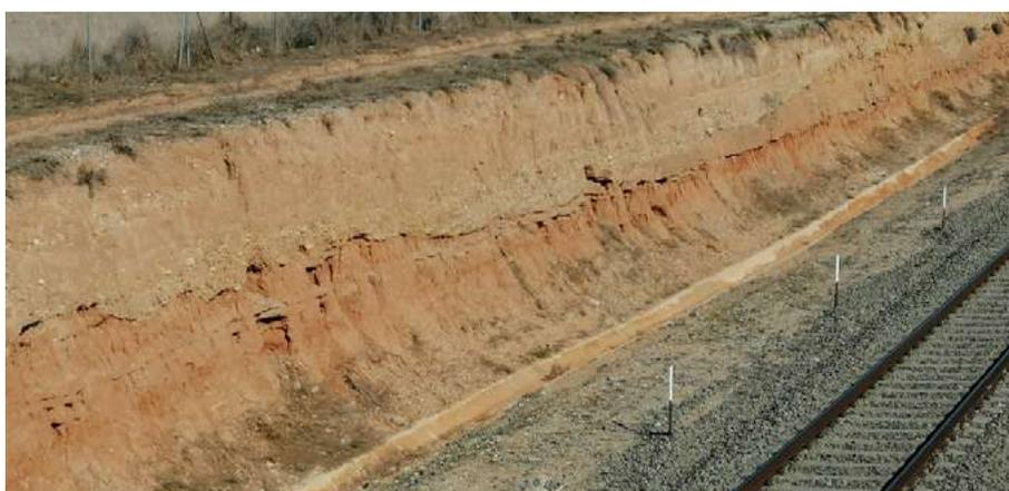
**Fotografía 4. Aspecto del afloramiento de materiales cuaternarios de tipo terraza en la trinchera del ferrocarril en la zona sur del municipio de Muel (aparecen apoyados con discordancia erosiva sobre las lutitas terciarias).**
